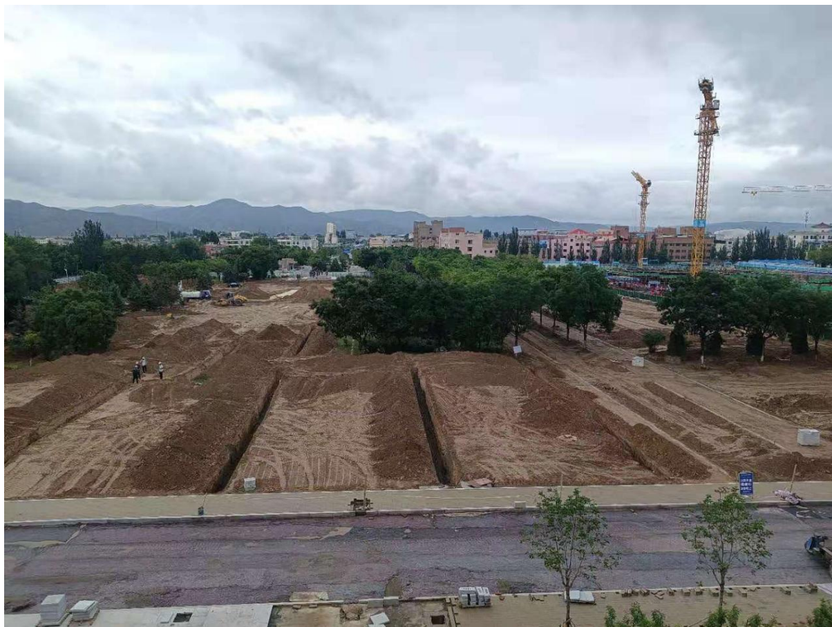
图16 榆中校区环境提升改造（一期）工程施工现状
