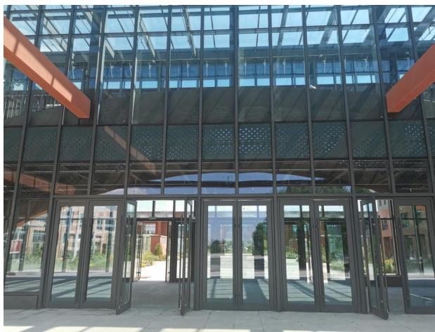
图11 钢连廊玻璃幕墙完成
