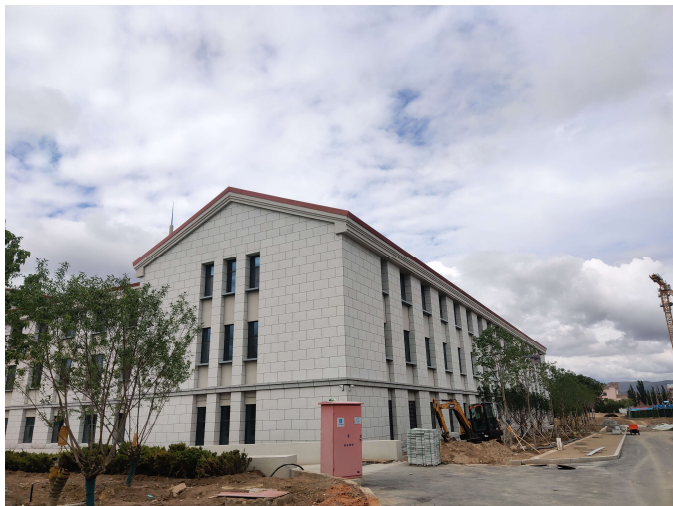
图7 南侧室外施工现状
