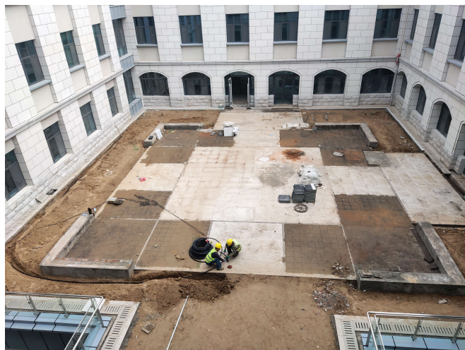
图4 内庭院施工现状
