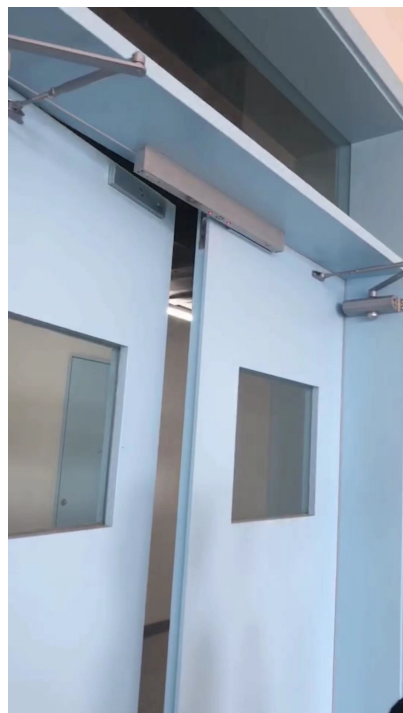
图14 门禁系统调试完成
