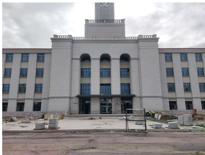
图6 东侧幕墙施工现状
