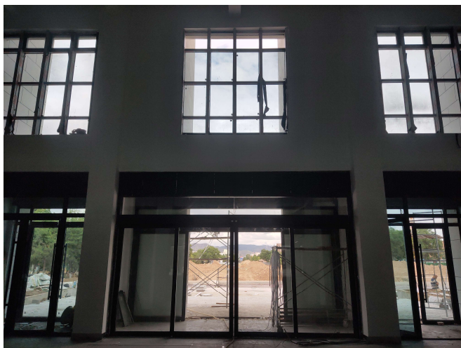
图3 东出入口门安装完成
