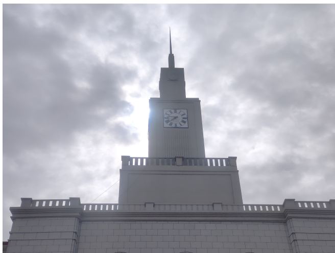
图1 屋面GRC栏杆安装完成
