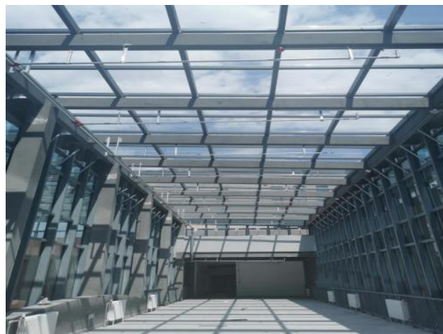
图12 钢连廊玻璃采光顶完成
