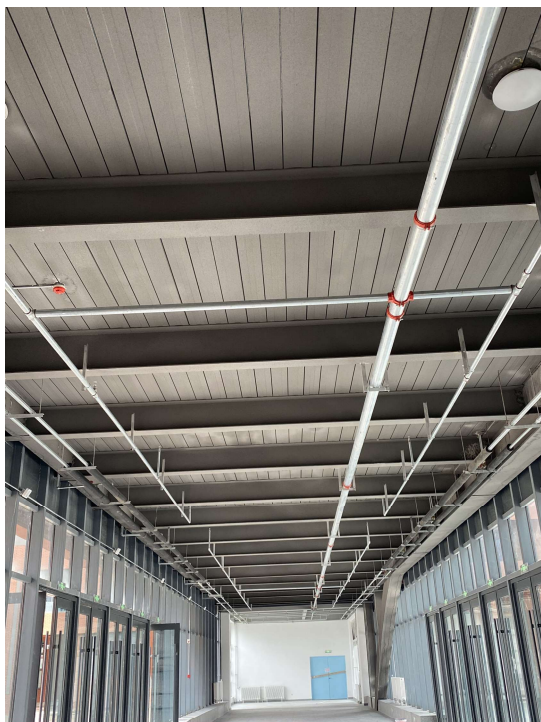
图13 钢连廊喷淋系统完成
