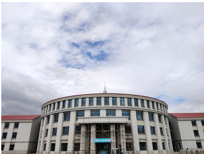
图5 西侧幕墙施工现状
