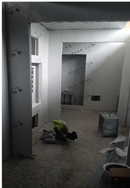
图18 超净室围护结构施工
