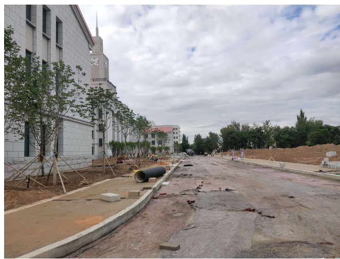
图8 东侧道路施工现状
