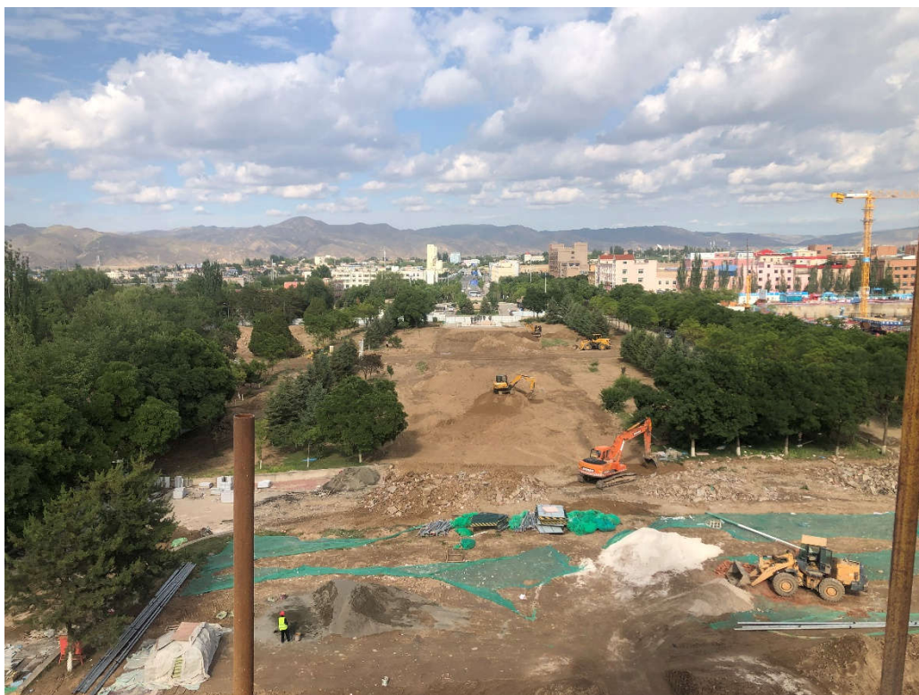
图17 榆中校区环境提升改造（一期）工程施工现状
