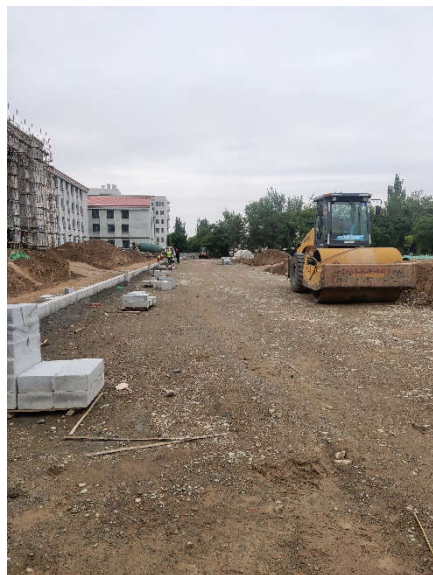
图8 东侧道路施工现状
