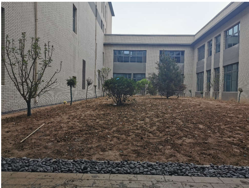
图13 内庭院施工现状
