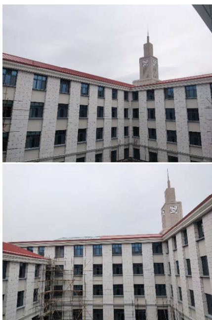
图5 内庭院幕墙施工现状
