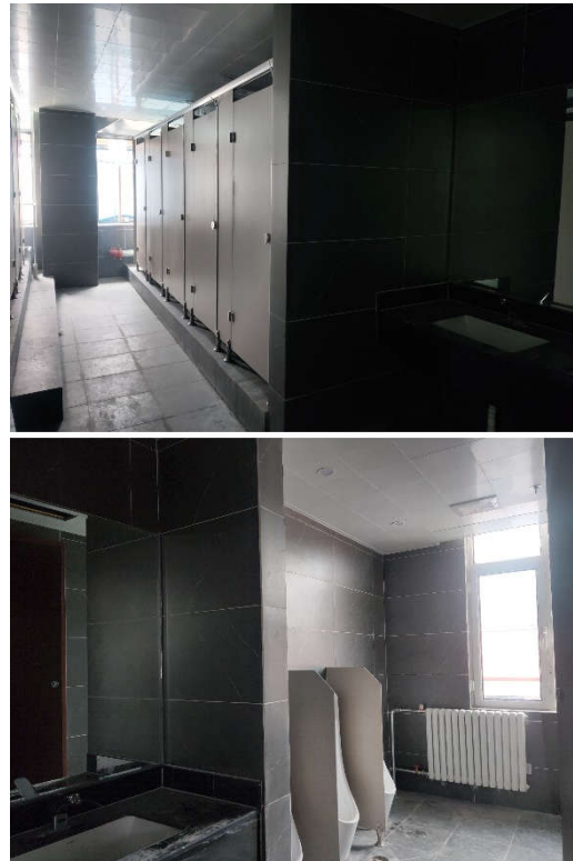
图4 卫生间施工完成
