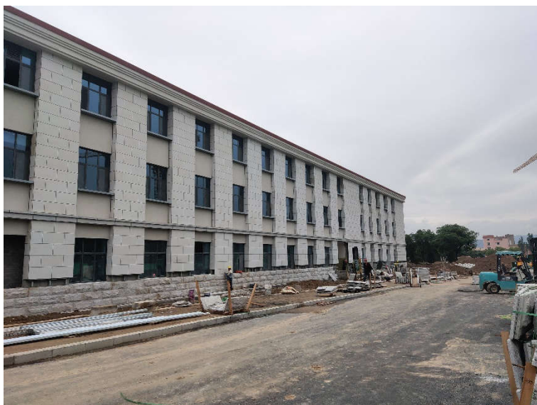
图7 南侧室外施工现状
