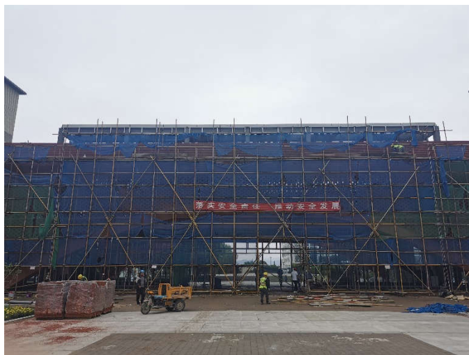
图12 钢连廊南侧装饰砖砌筑
