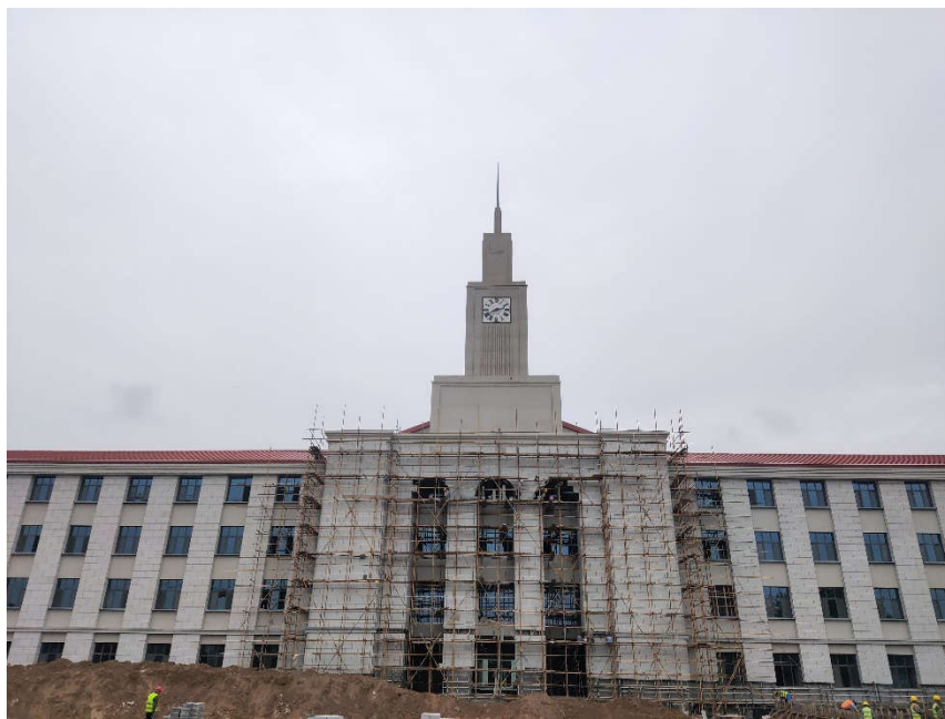
图6 东侧幕墙施工现状
