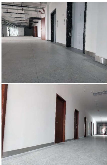
图2 2-4层不锈钢踢脚完成
