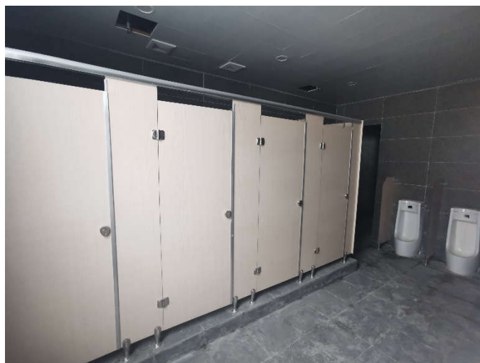
图11 卫生间施工完成
