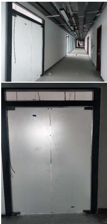
图3 3层玻璃隔断门安装完成
