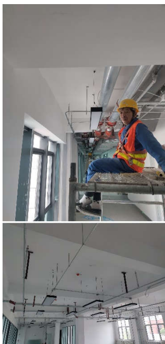
图9 2层室内灯具安装
