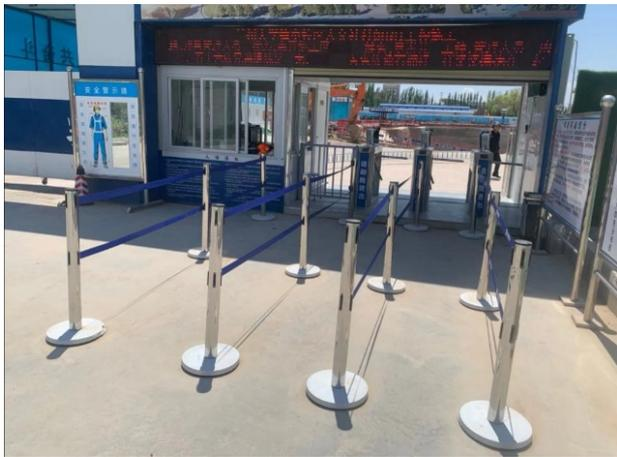
图15 施工现场主入口劳务实名制设备
