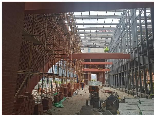
图11 第二实验楼钢连廊装饰砖及幕墙施工
