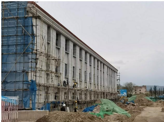
图2 综合楼南侧幕墙石材及真石漆完成
