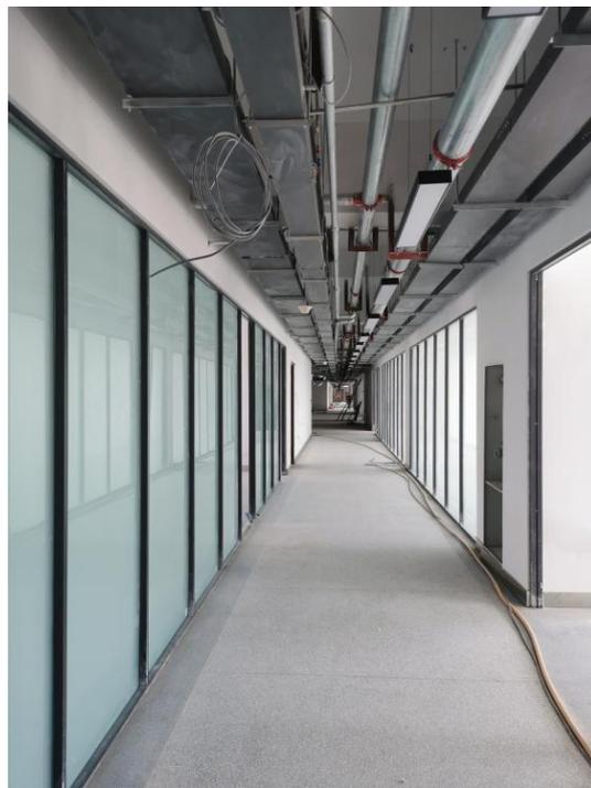
图4 3层玻璃隔断玻璃安装完成
