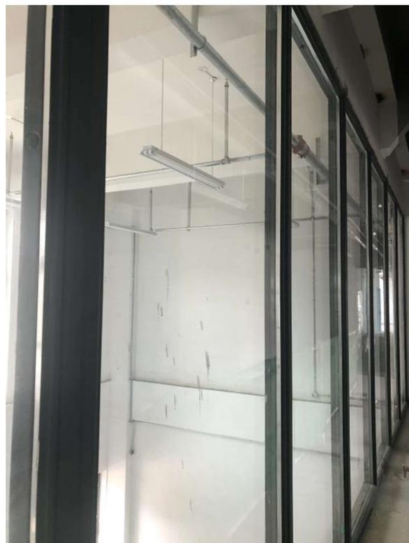
图11 防火玻璃隔断
