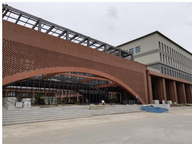
图13 钢连廊南侧装饰砖砌筑完成
